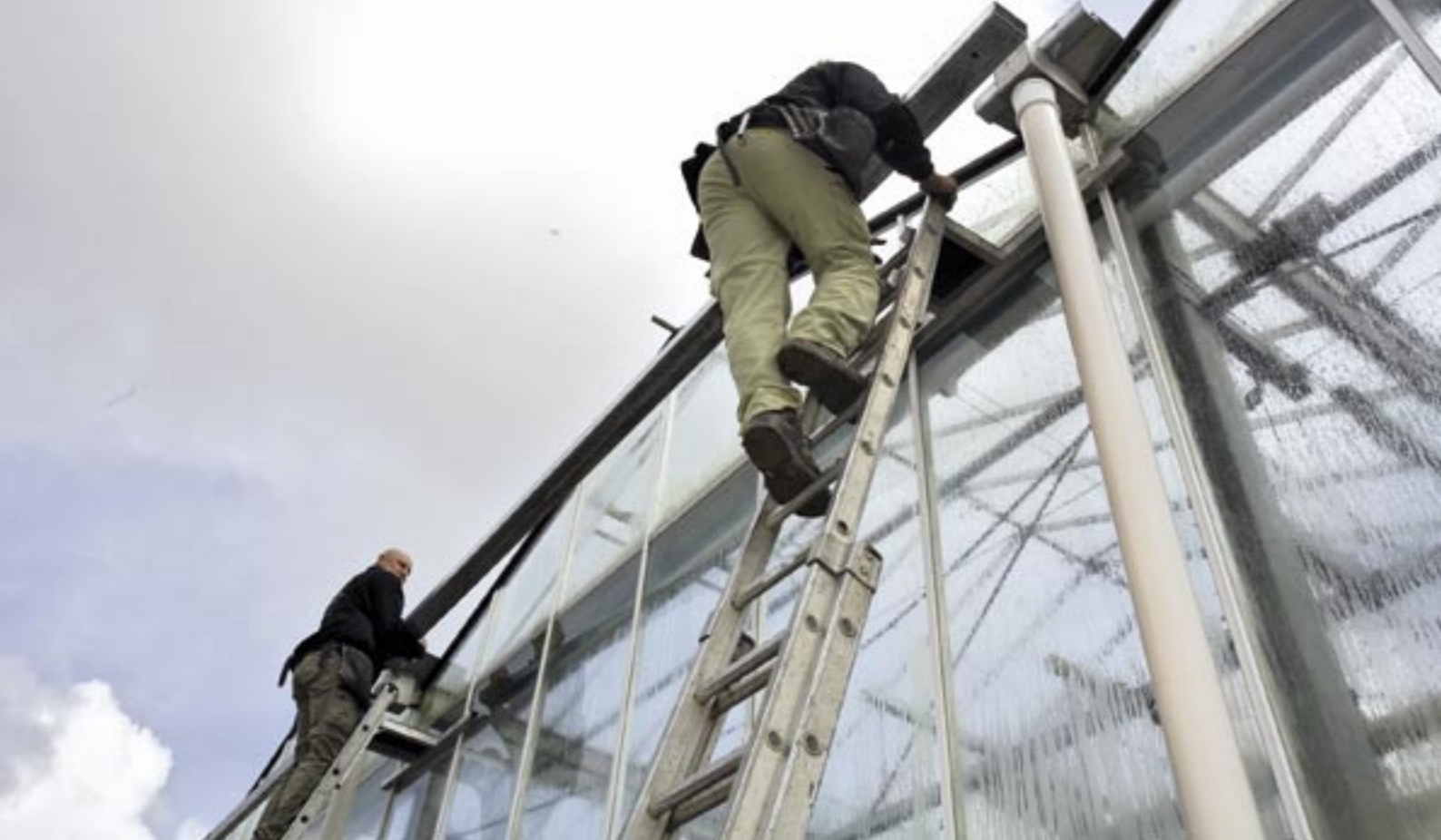
Een betrouwbare servicerail, die op voldoende sterke gootconsoles rust, speelt bij de veiligheid op en rond kassen een hoofdrol.
